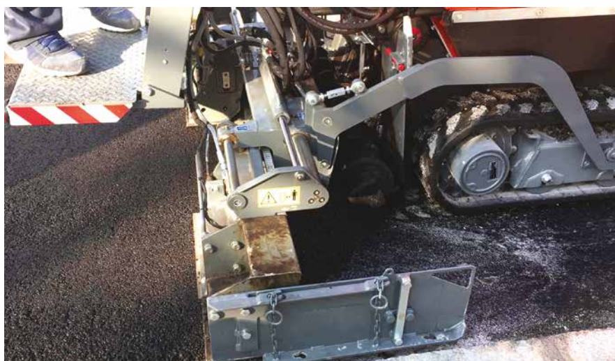
3. Un particolare del rasatore S175V, con le estensioni meccaniche montate per l'asfaltatura di un marciapiede
