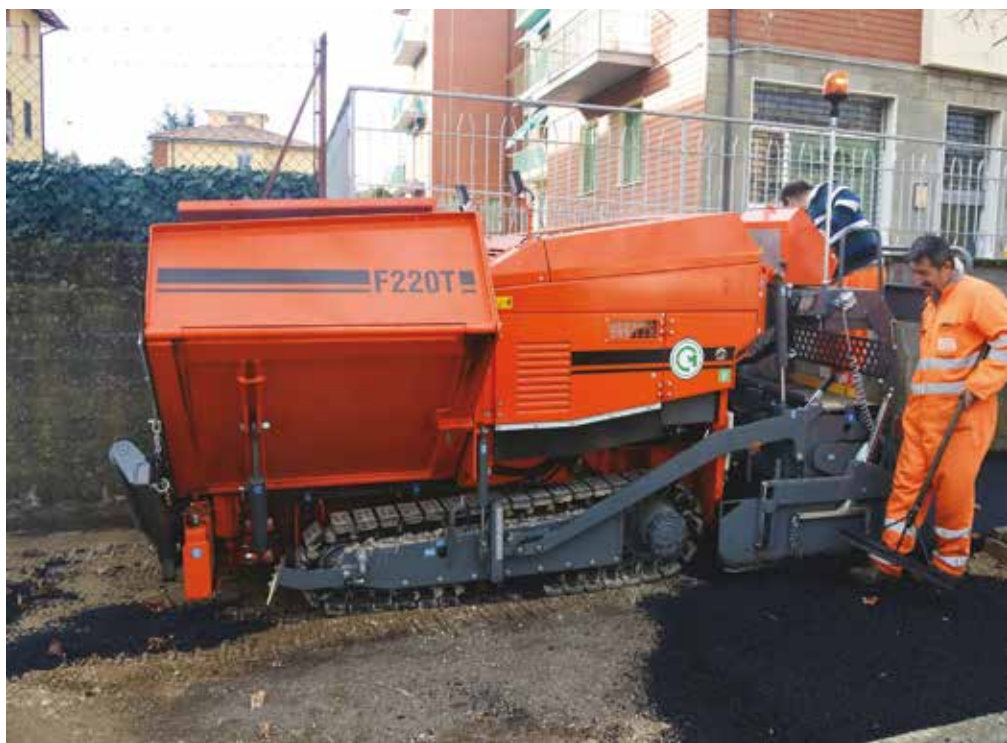
7. Asfaltatura di un ampio marciapiede a Castel San Pietro Terme (BO) con la Vibrofinitrice F220T
