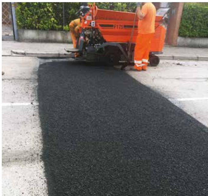
2. La finitrice F175 all'opera nel ripristino di uno scavo per la posa di servizi ad Albignasego (PD)
