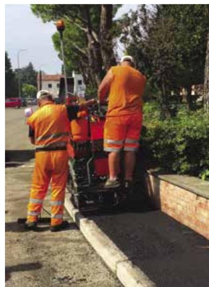
**LA VIBROFINITRICE GOMMATA CM F175 MONTA UN MOTORE HATZ DA 7,6 KW. È DOTATA DI RASATORE ESTENSIBILE CON COMANDI IDRAULICI E DI TRAMOGGIA FISSA CON PARATIE LATERALI RIBALTABILI**
